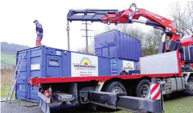
Verlad der grossen Wärmemobil-Einheiten mit schwerem Gerät.
